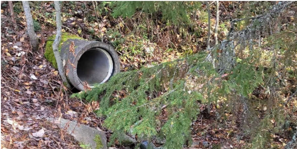
Figur 26: Trumma som löper genom traktorvägen. Foto taget nedströms. Bild från den geotekniska utredningen (Tyréns, 2023).
